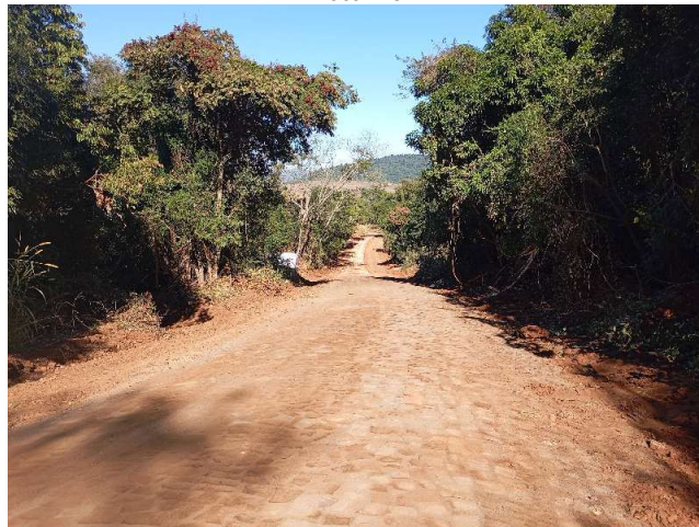
Pavimentação Poliedrica Jundiá do Sul Latitude: -23.411605 Longitude: -50.253221 Data:12/08/2025
