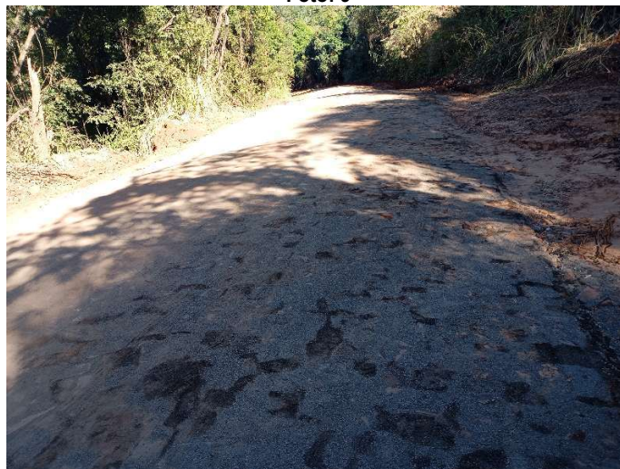
Pavimentação Poliedrica Jundiá do Sul Latitude: -23.41159 Longitude: -50.252959 Data: 12/08/2025
