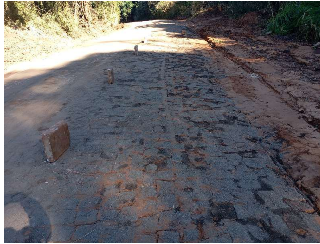
Pavimentação Poliedrica Jundiá do Sul Latitude: -23.41159 Longitude: -50.252959 Data: 12/08/2025
