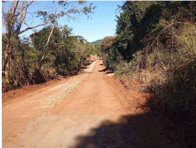
Pavimentação Poliedrica Jundiá do Sul Latitude: -23.411931 Longitude: -50.254527 Data:12/08/2025
