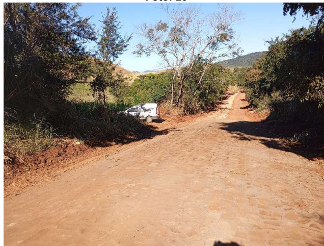
Pavimentação Poliedrica Jundiá do Sul Latitude: -23.411793 Longitude: -50.254289 Data:12/08/2025
