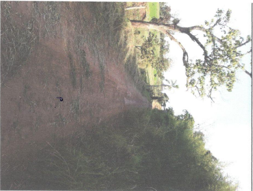
Foto 1 – Trecho 4.2 Mostra a necessidade de bueiro e alargamento e abaulamento da estrada
